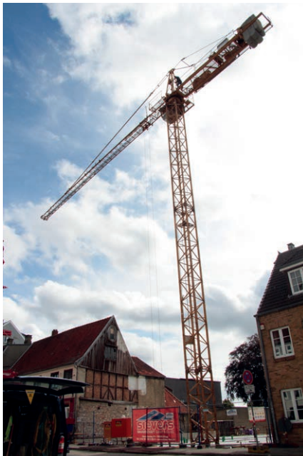
Der riesige Kran weist schon von weitem den Weg zum Neubau des Verwaltungsgebäudes.
