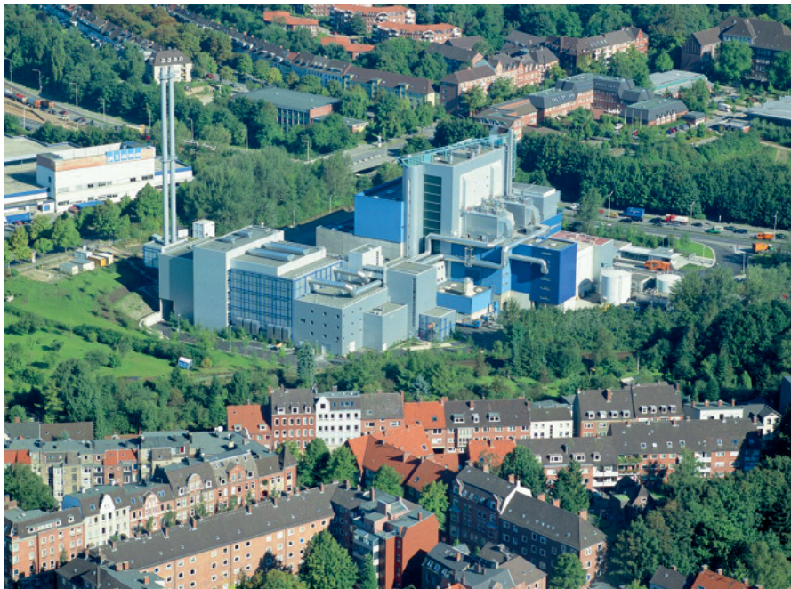
Das Müllheizkraftwerk Kiel am Theodor-Heuss-Ring: Ein ganz heißer Ofen
